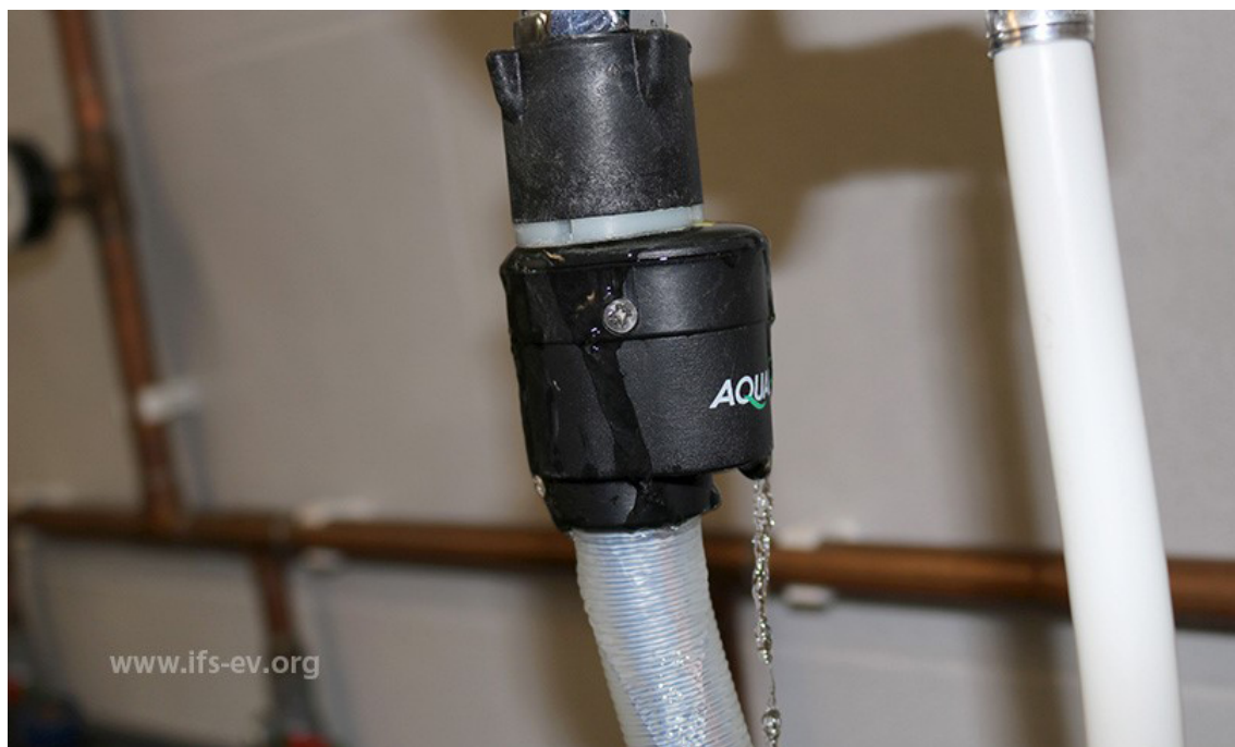
Der Geschirrspüleranschluss bei der Dichtigkeitsprüfung im IFS. Foto: www.ifs-ev.org .
