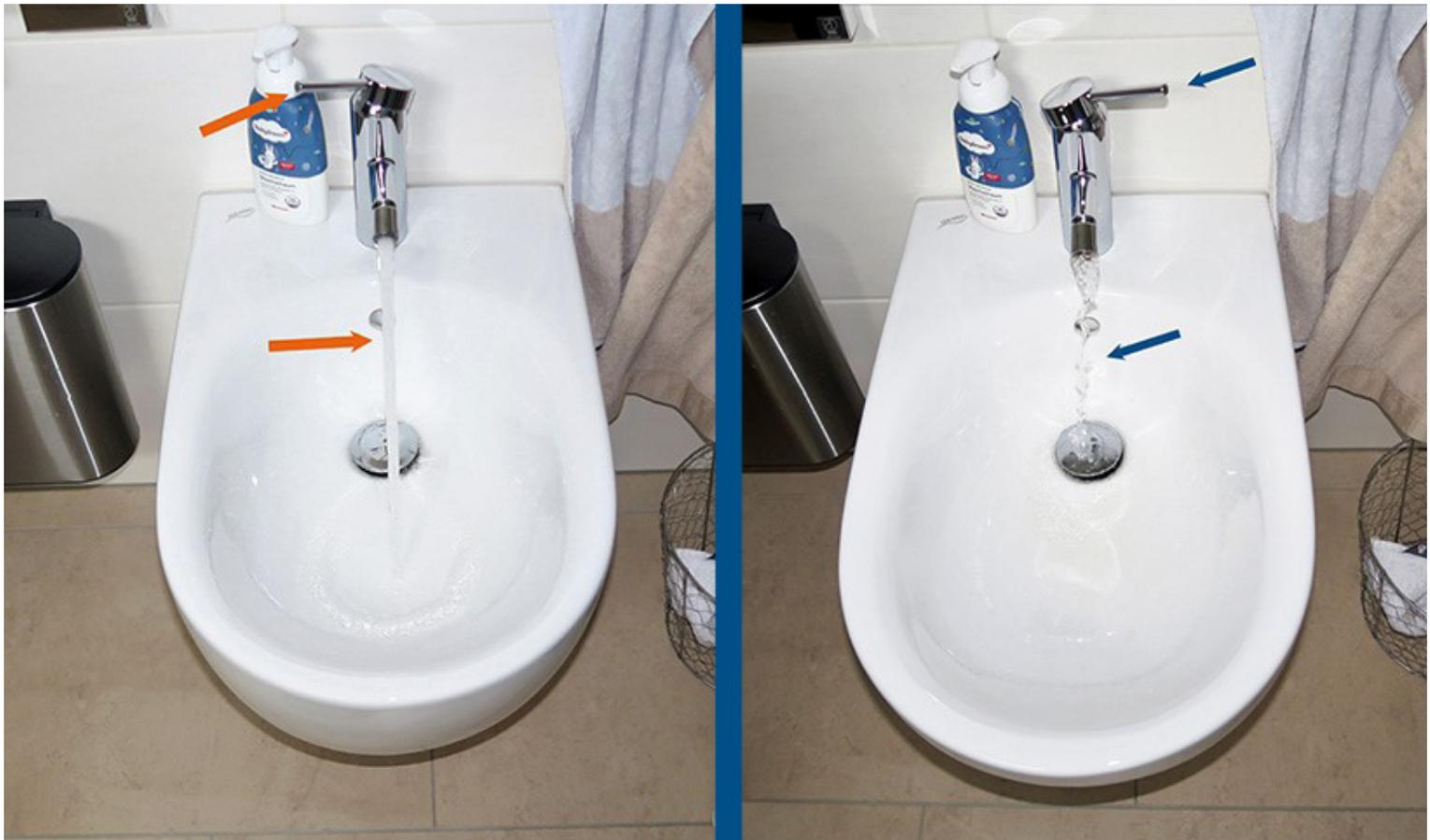
Die Aufnahmen rechts und in der Mitte zeigen das Bidet im Gäste-Bad. Bei der Entnahme von Kaltwasser (rechts) ist die maximale Entnahmerate erheblich reduziert, während sie bei Entnahme von Warmwasser (Mitte) in vollem Umfang zur Verfügung steht. Foto: [www.ifs-ev.org](http://www.ifs-ev.org).
