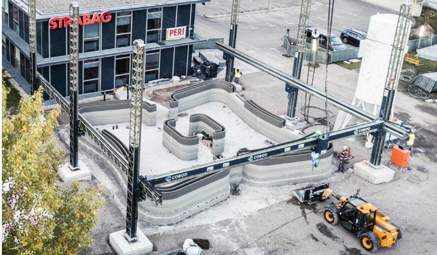
Der Strabag-Bau im niederösterreichischen Hausleiten während des Druckvorgangs. Der Portaldrucker von Peri muss nur einmal kalibriert werden, dann druckt er los
