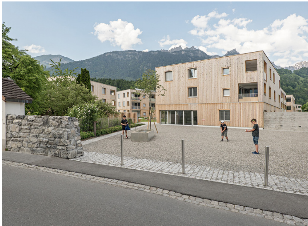
Marterl und Linde: Der „Quartiersplatz“ fungiert als Auftakt und Verbindung zur angrenzenden Siedlung
