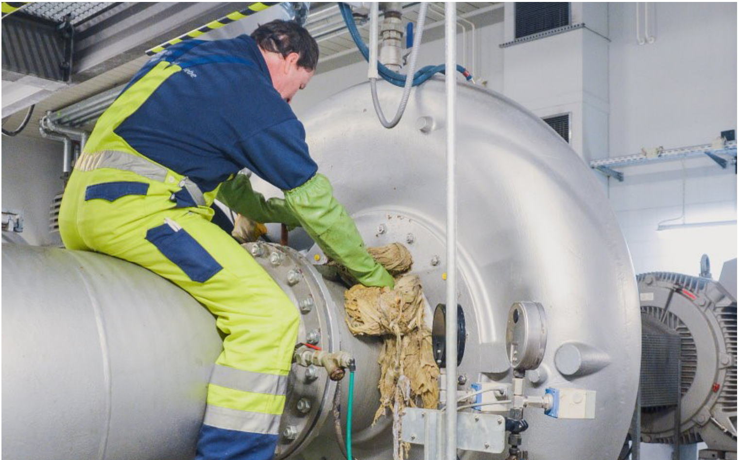
Entstörungsdienst beim Entfernen einer „Verzopfung“, denn Feuchttücher (Microfasertücher) sind das neue Problem. Foto: BWB Berliner Wasserbetriebe
