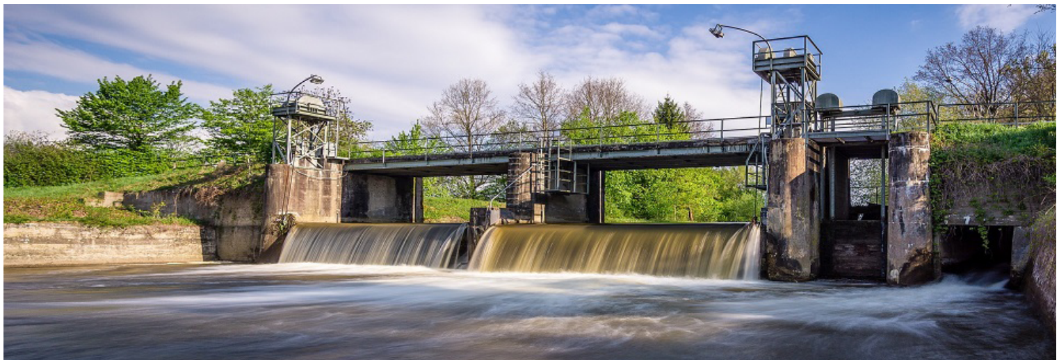
Ein „kleines Wasserwerk“. Foto: BDW
