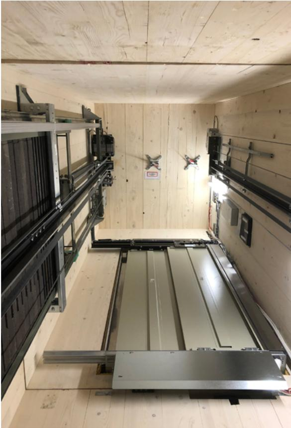
Holzbau macht Schule: Auch der Aufzugschacht besteht vollständig aus dem nachwachsenden Rohstoff. Foto: Schindler
