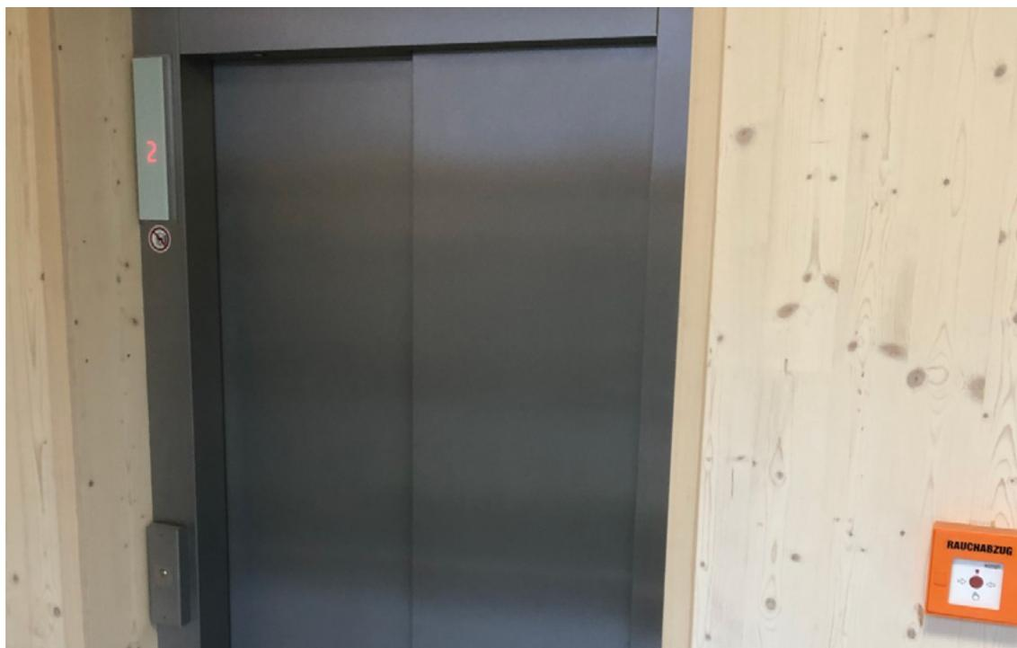
Der Schindler 3000 sorgt in den Schulen für barrierefreie Mobilität. In einen Holzschacht lassen sich aber auch andere Modelle des Schweizer Herstellers integrieren. Foto: Schindler
