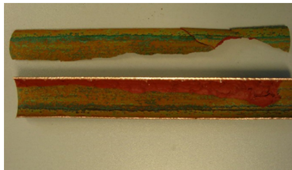
Bild 6: Abplatzen der Beschichtung
