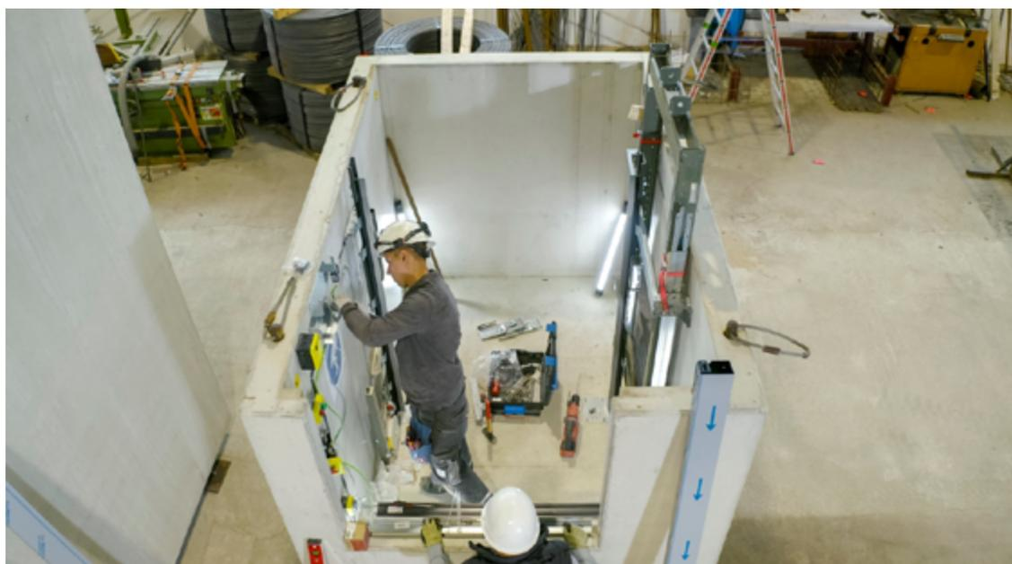
Trocken und ebenerdig: Die Technik wird bereits in der Halle in die Schacht-Elemente eingebaut. Foto: Schindler
