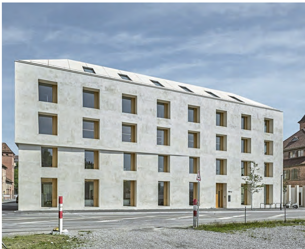
Vorbildhaft: CO 2 -neutraler Wohnbau 2226 in Emmen, Schweiz, von Baumschlagler Eberle
