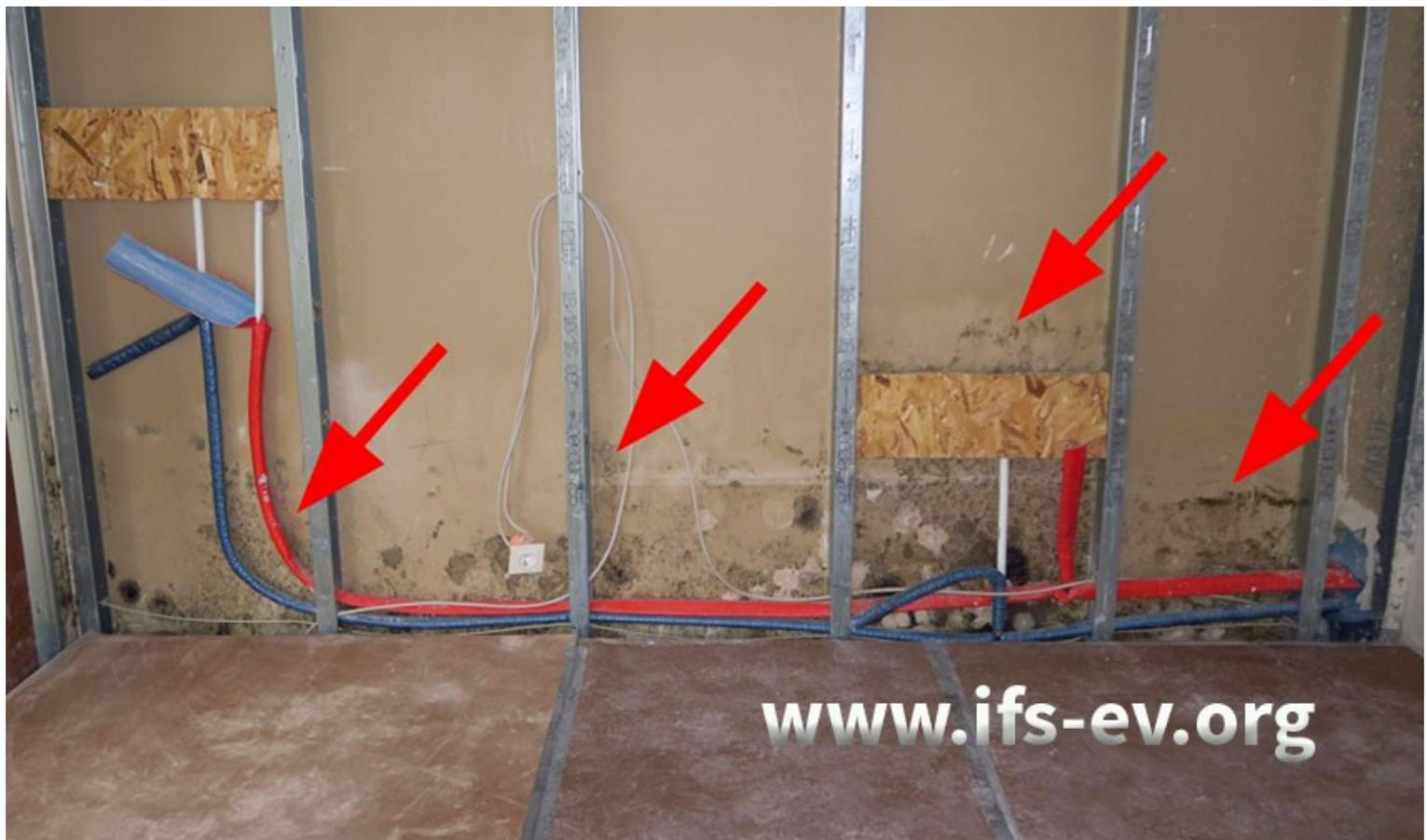
In der geöffneten Leichtbauwand, hinter der sich die Badewanne und die Dusche befinden, ist Schimmelfall zu sehen. Foto: [Feuchte- und Schimmelpilzschäden](https://www.ifs-ev.org/) › Institut für Schadenverhütung und Schadenforschung der öffentlichen Versicherer e.V. (ifs-ev.org)
