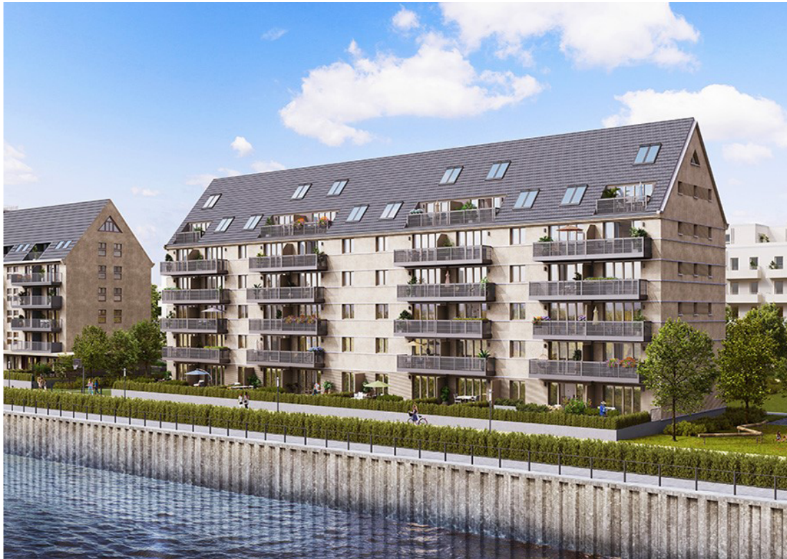
Der Neubau HAVEL-SPEICHER Quelle: BUWOG
