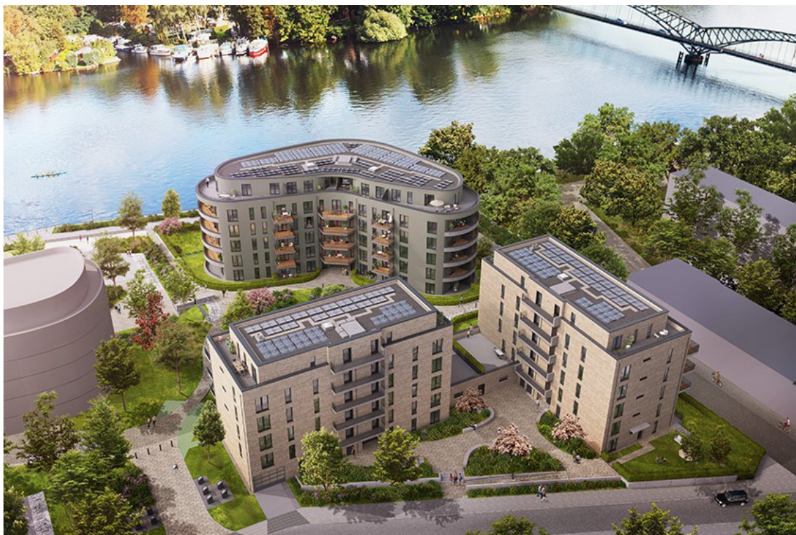
BUWOG SPEICHERBALLETT: Solarmodule auf den Flachdächern Quelle: BUWOG
