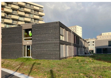
Temporäres, klimafittes und kostengünstiges Studenten-Wohnen in den Pop-up-Dorms in der Seestadt Aspern
