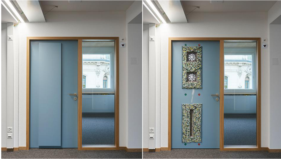
Verbundlüfter in den Türen (rechts ohne, links mit Abdeckung) sorgen für die Luftzirkulation zwischen Büros und Korridor. Foto: © Laura Egger/Mettiss AG
