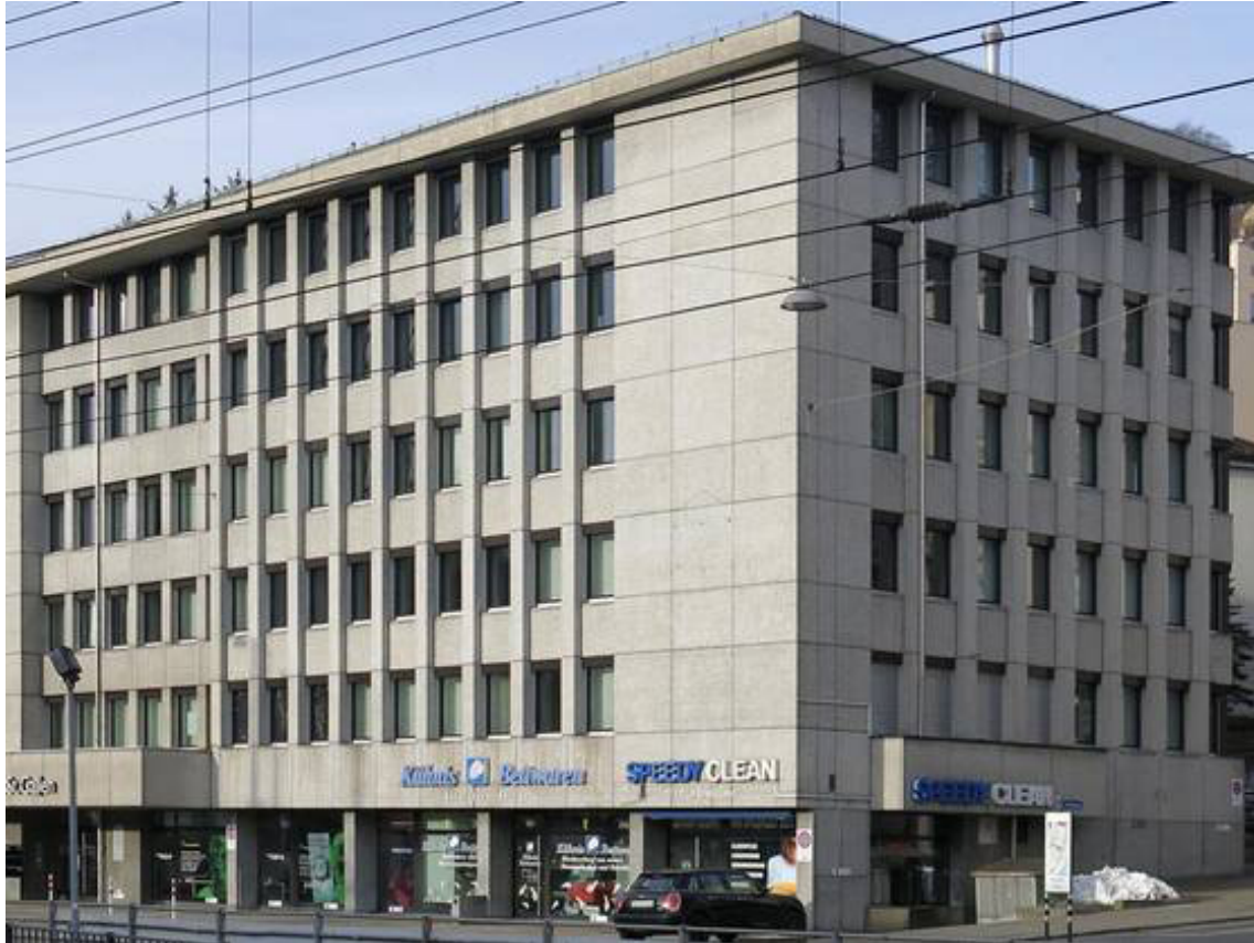
Vielorts Kandidaten für den sicheren Abriss: Wohn- und Gewerbebauten der 1960er und 70er Jahre, wie hier das Geschäftshaus Rosenbergstraße 30 in St. Gallen. Foto: © Mettiss AG
