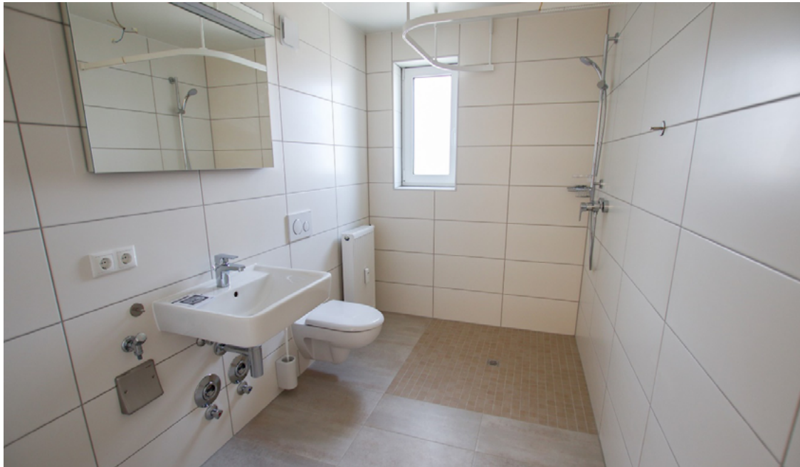
Barrierefrei: Die Badezimmer kamen als fertig montierte Raummodule auf die Baustelle. Bodengleiche Dusche inklusive. Foto: Dennert
