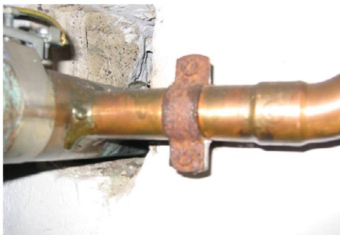
**Bild 1:** Kupferinstallation mit verzinkter Stahlschelle
