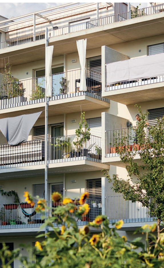
Die Bewohner setzen beim Wohnbau an der Glan das üppige Grün fort.
