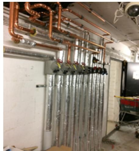
Als Erkenntnis aus dem Austausch im AVW Forum Leitungswasser: Verzicht auf Verbundrohre in den Steige- und Kellerverteilsituationen, grundsätzlicher Einsatz von rein metallischen Leitungssystemen.
