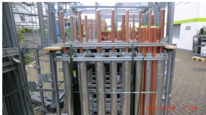
Im Versorgungschacht bündeln sich alle Leitungen mit den unterschiedlichen Aufgaben, wie Trinkwasser (warm und kalt), Heizung (Vor- und Rücklauf) und Abwasser. Dieses Rohrsystem muss genau geplant und verlegt werden, damit auch die jeweiligen Anforderungen erfüllt werden können. Dabei spielt der Abstand zueinander, der Rohrumfang, der jeweilige Druck, eine große Rolle.
