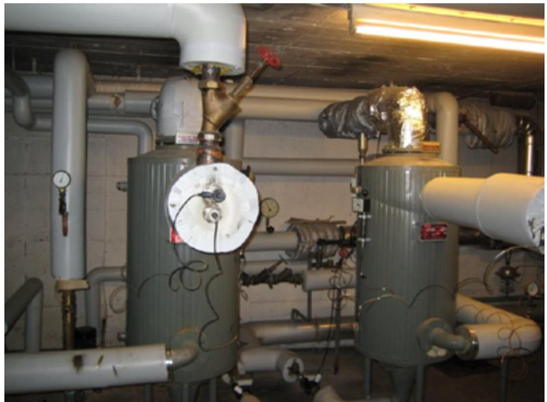
Auch wenn die Warmwasser-Anlage auf den ersten Blick noch gut aussieht, muss man nach einer „Laufzeit“ von ca. 50 Jahren durchaus mit Schäden durch Materialermüdung rechnen. Hier besonders, wenn sich plötzlich der Wasserdruck stark verändert.
