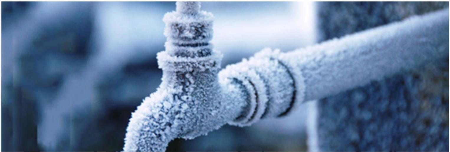
Der erste Frost mit Raureif auf der Wasserleitung. Ist die Leitung bis zum Abstellhahn leer, kann eigentlich nichts passieren. Probleme gibt es, wenn Wasser draußen bis zum Hahn ansteht. Bei Frost gefriert es und das Eis presst gegen die Leitung bis Haarrisse entstehen, oder schlimmer, die Leitung platzt... Solange Eis im Rohr ist droft es kaum, wenn taut, dann strudelt der Wasser... Foto: GDV
