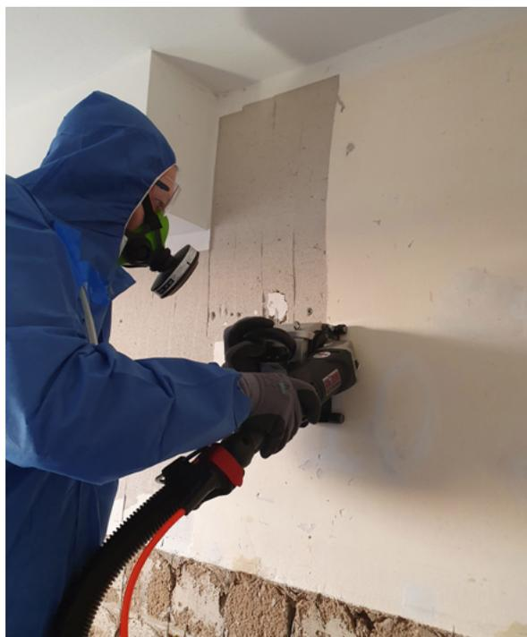
Innovativ: Mit dem SES-NHW-Verfahren ist eine emissionsarme Sanierung asbesthaltiger Wandflächen möglich. Foto: NHW
