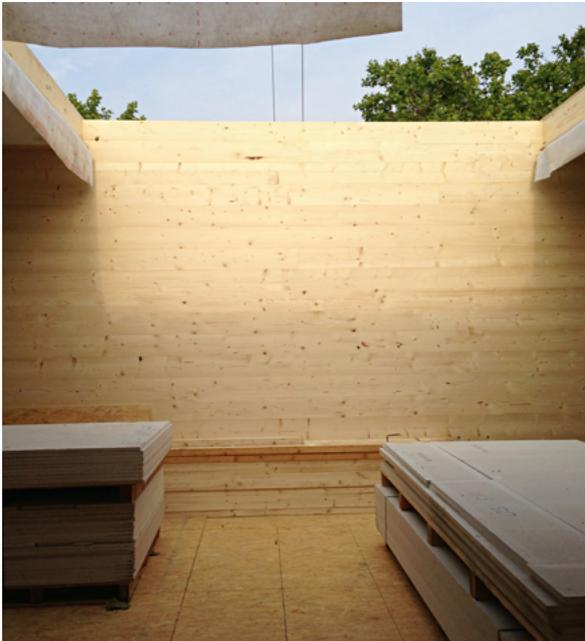
Durch die Vorfertigung im Holzbau lässt sich eine zügige Fertigstellung sicherstellen. Wichtig war hier insbesondere die Vor-Elementierung der Decken- und Dachbauteile, um einen schnellen und trockenen Bauablauf zu gewährleisten. Foto: Pirmin Jung GmbH
