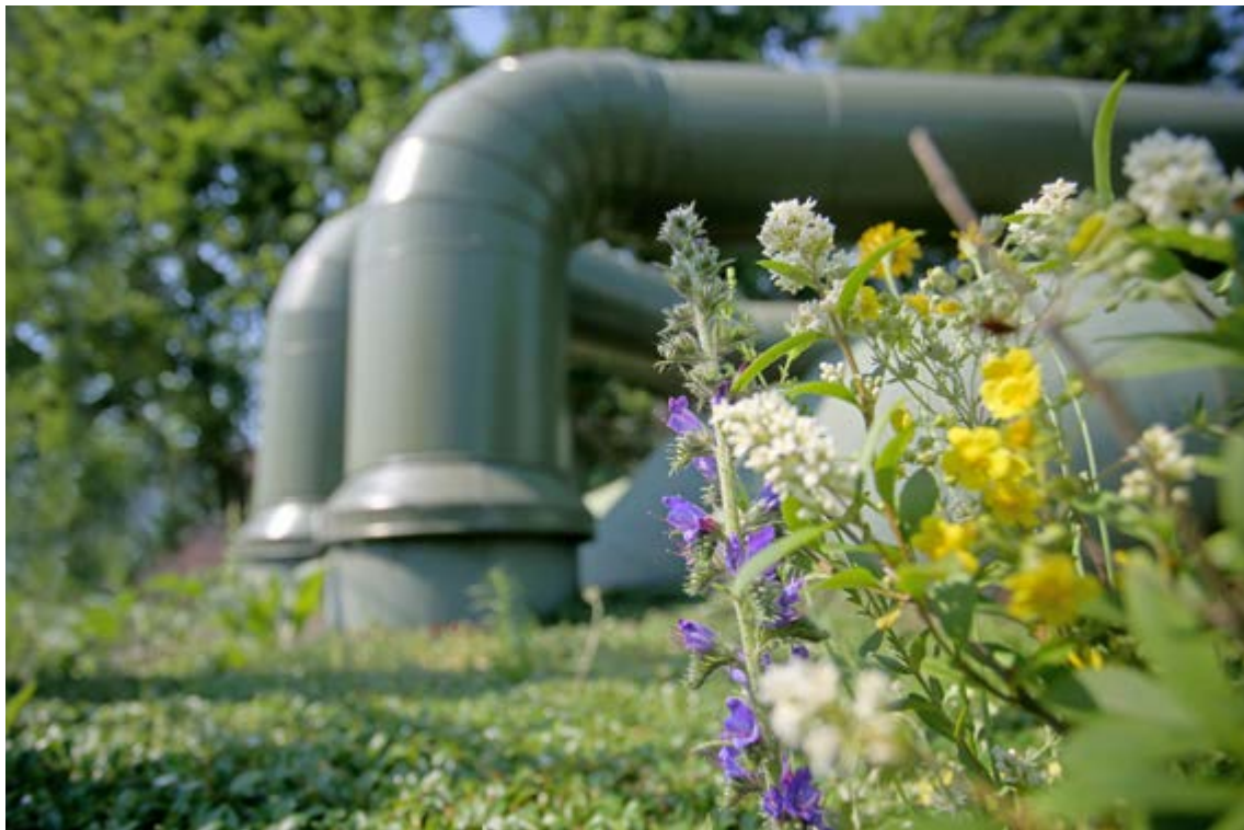
Fernwärme wird umweltfreundlich. Foto: enercity
