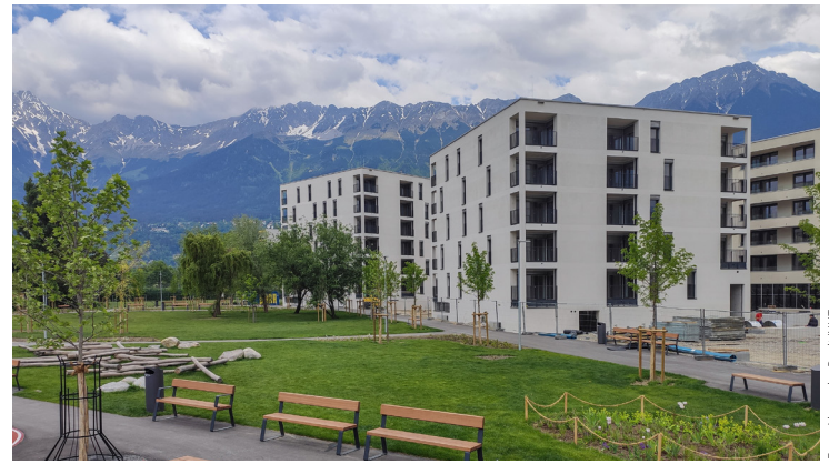
Freiraumfluss ohne Zäune im Werden: „Wohnen am Park“ in Innsbruck-Pradl.
