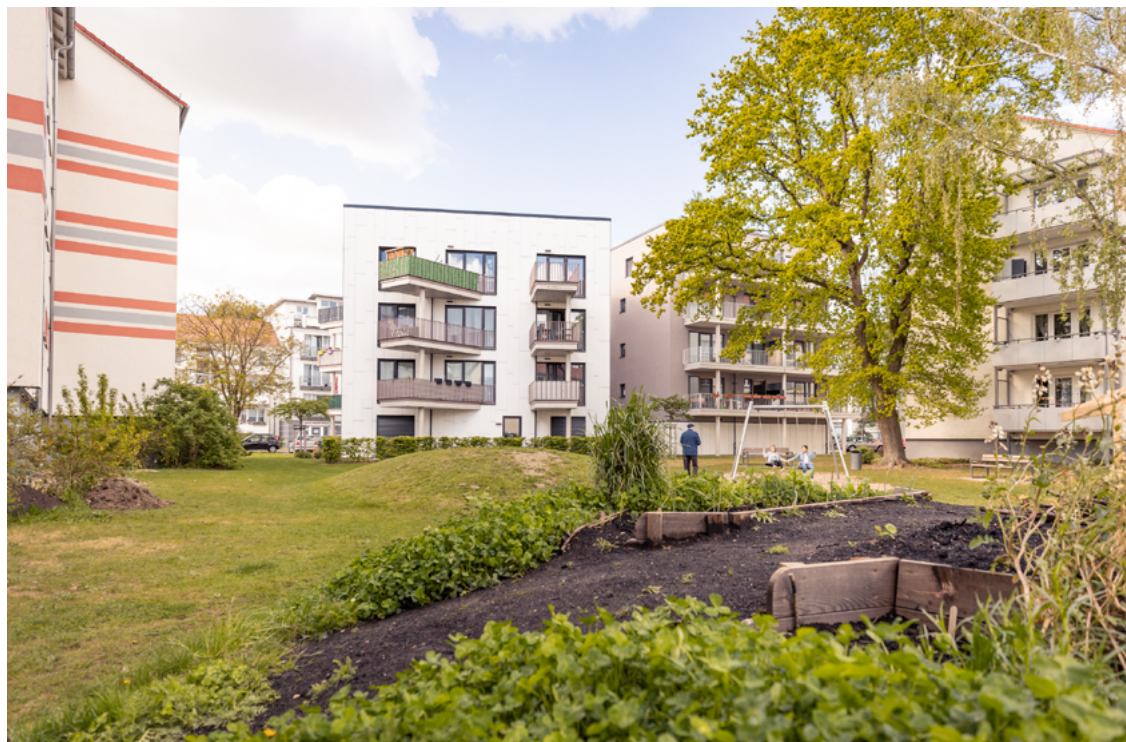
Klimaschutz zeigt sich auch in den Grünflächengestaltung. Hier ein Innenhof in einer Wohnanlage in Huchtingen. Foto: GEWOBA
