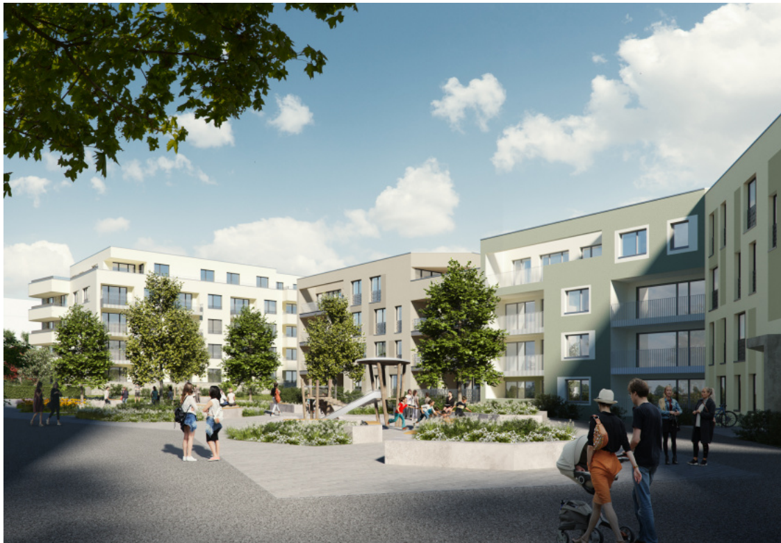
Ein Blick auf den Quartiersplatz. Foto: GWW
