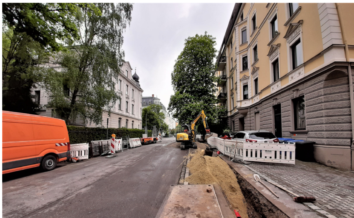
Startschuss für die zweite Glasfaseroffensive der Stadtwerke Augsburg (swa) und M-net: Im Bismarckviertel werden rund 214 Wohnungen an das schnelle Glasfaser-Netz angebunden. Foto: swa / Marie-Therese Abler
