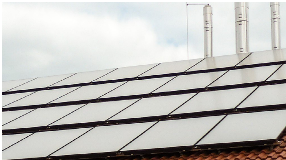
Eine PV-Anlage zur Gewinnung von Mieterstrom. Foto: Gerd Warda
