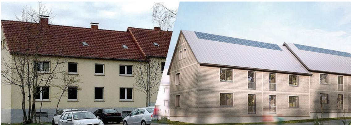
Durch die Sanierung mit vorgefertigten Dach- und Fassadenelementen sowie nachhaltiger Heiztechnik, wie Wärmepumpen und Stromerzeugung sollen die Gebäude auf Net-Zero-Standard gebracht werden. Fotos: arsago Gruppe. Mehr Informationen finden Sie hier. [KLICKEN](#) Sie einfach auf das Bild und das PDF öffnet sich
