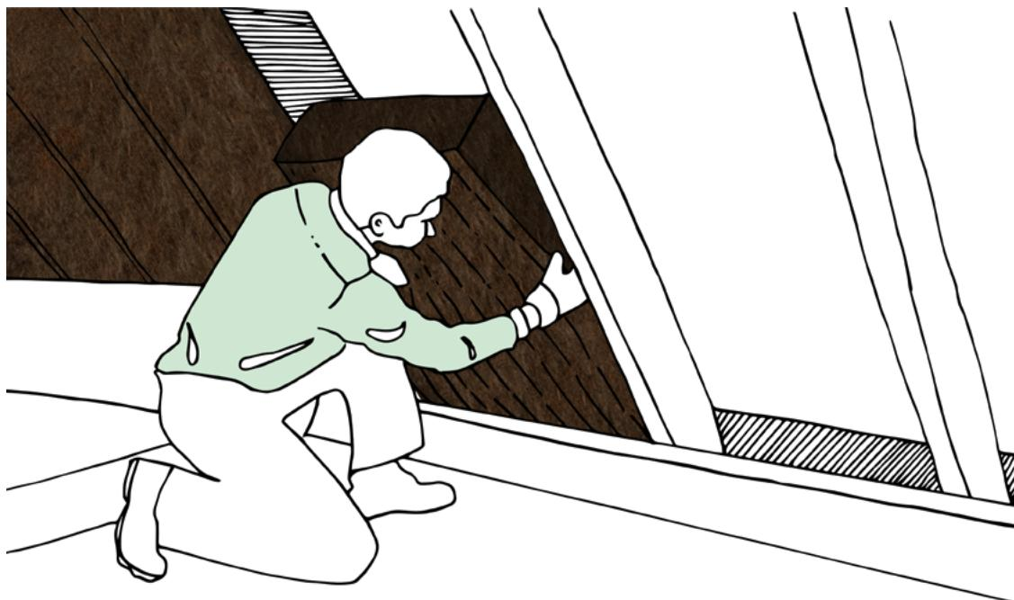
Dämmung unterm Dach: Eine Zwischensparrendämmung aus Mineralwolle (Glaswolle oder Steinwolle) kann problemlos in Eigenregie eingebaut werden.
