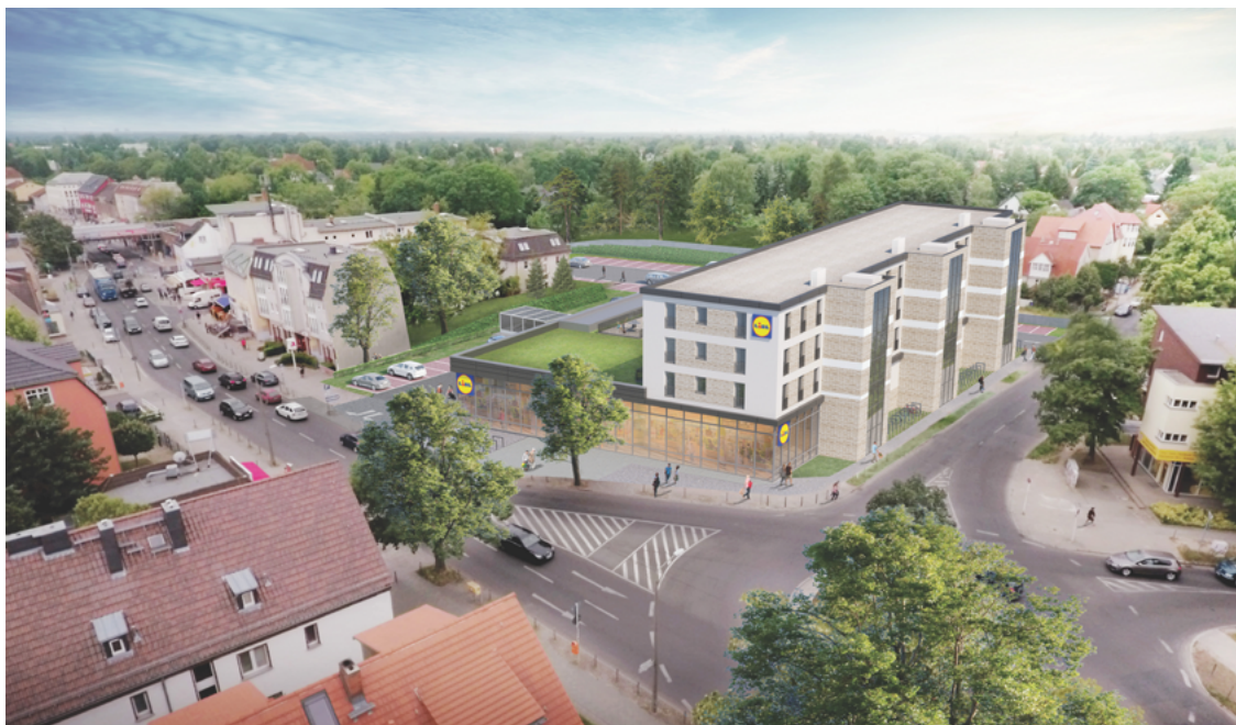
Luftbild der Lidl-Projektentwicklung in der Hönower Straße. Bildquelle: Lidl Deutschland. Copyright Firmengruppe Max Bögl
