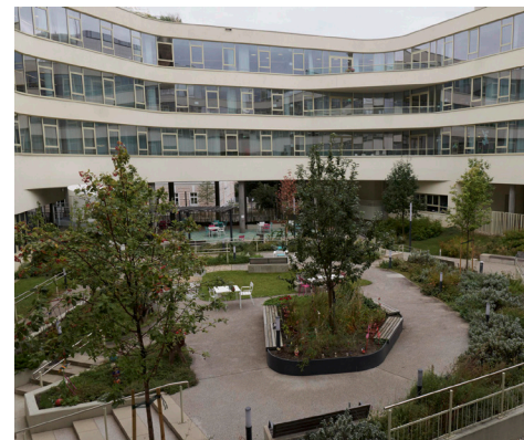
Innenhof des Pflegewohnhauses Rudolfsheim: Spazieren, Verweilen und Natur mitten in der Stadt genießen.
