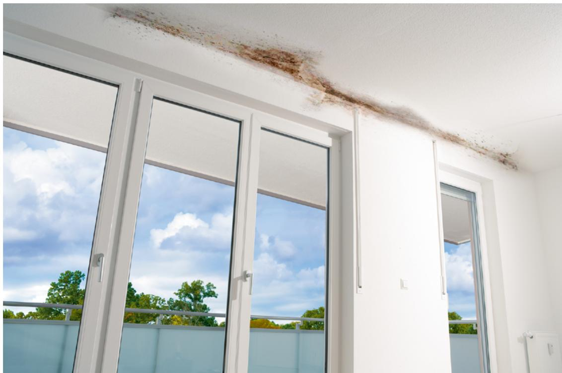
Auskragungen zählen unter anderem zu den kritischsten Wärmebrücken in der Gebäudehülle und sind besonders anfällig für Schimmelpilzbildung. Foto: Schöck Bauteile
