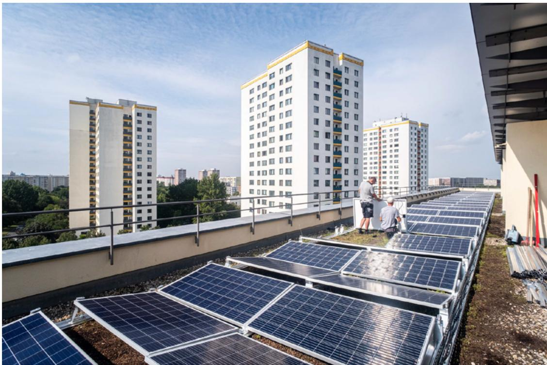
Die Solarmodule stehen auf dem Gründach. Durch die Verdunstung gibt es einen Kühleffekt, die Folge: Die Module liefern mehr Strom. Foto: degewo
