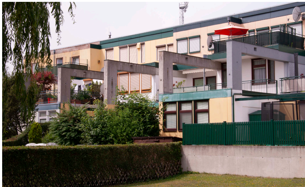
Stützen tragen die Wohnhausanlage „Wohnen morgen“ in Hollabrunn, die in den 1970er Jahren errichtet wurde.
