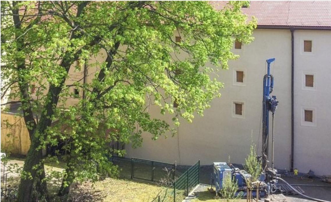
Kornhaus in Freiberg, Außenansicht Mit z.T. 205 Meter Bohrtiefe verfügt das Kornhaus über die tiefsten Sondenbohrungen des Freistaats Sachsen. (Bildquelle: Rudi Grimm / geoENERGIE Konzept).
