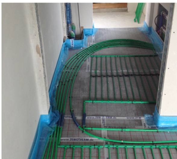
Eine Fußbodenheizung wurde im ganzen Haus verlegt. Im Winter gibt sie die geforderte Wärme ab, im Sommer kann gekühlt werden. Foto: Geocollect
