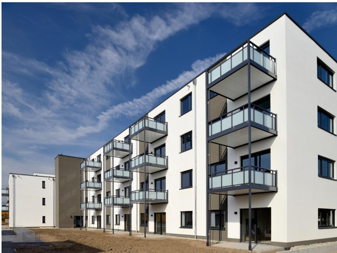
Als einer der ersten Hersteller von Gebäuden in Stahlmodulbauweise bietet ALHO ausgefeilte Lösungen im Geschosswohnungsbau. Aus einem Kanon unterschiedlicher Module werden – maßgeschneidert für den jeweiligen Standort und nach Vorgabe des gewünschten Wohnungsschlüssels – die Wohnungen entwickelt. ALHO Holding GmbH
