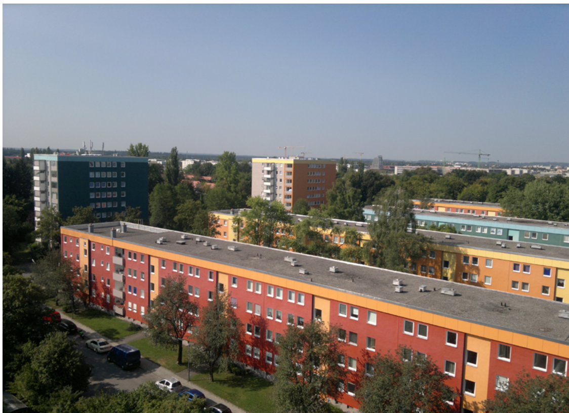
Die 50 Jahre alte Wohnanlage in München mit 675 Wohnungen erhält Fernwärme. Foto: Heimbau Bayern
