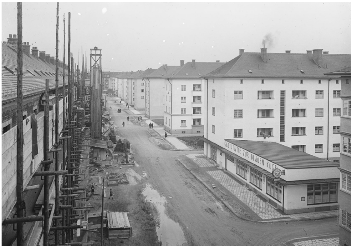
Baustelle der Siedlung Neuhäusen um 1930 (Foto: GEWOFAG)
