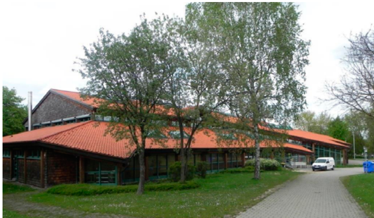
Neuhausen vorsorgt ein Nahwärmezentrum auch Schule und Rathaus. Foto: Karsten Jänkel
