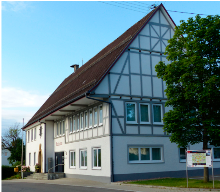
Mit Contracting beim Heizen Geld sparen. Rathaus Zimmern ob Rottweil. Foto: Gemeinde Zimmern
