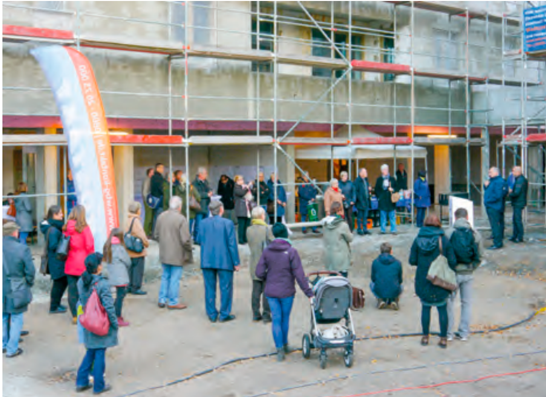
Zahlreiche Interessierte waren der Einladung zum Tag der offenen Baustelle gefolgt. Foto: WBG Kontakt
