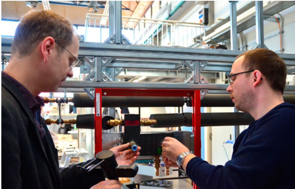
Prof. Dr. Carsten Bäcker (l.) und Stefan Brodale schließen eine Armatur an ihr aufgebautes Trinkwasser-Installationsmodell mit Warm- und Kaltwasserleitung an. (Foto: FH Münster/Pressestelle)
