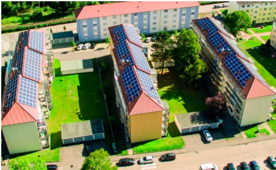
Mieterstrom für die Mieter der Baugenossenschaft Familienheim Mosbach eG. © WIRSOL
