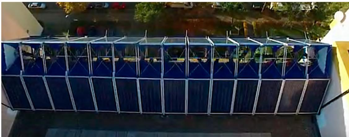
Innen Windkraftanlagen und außen Photovoltaik, alles findet Platz oben auf einer Dachkante.
