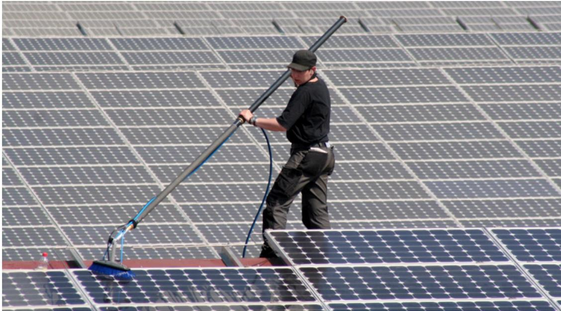
Verschmutzung der Photovoltaikanlagen bringen bis zu einem 30 Prozent niedrigeren Solarertrag. Foto: Niederberger
