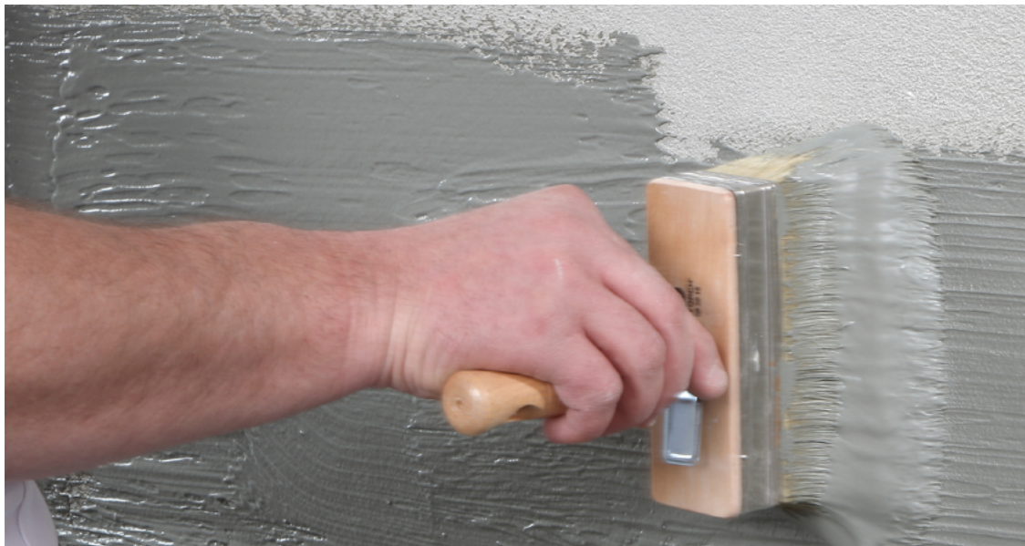
Innenabdichtung; Foto Heck
