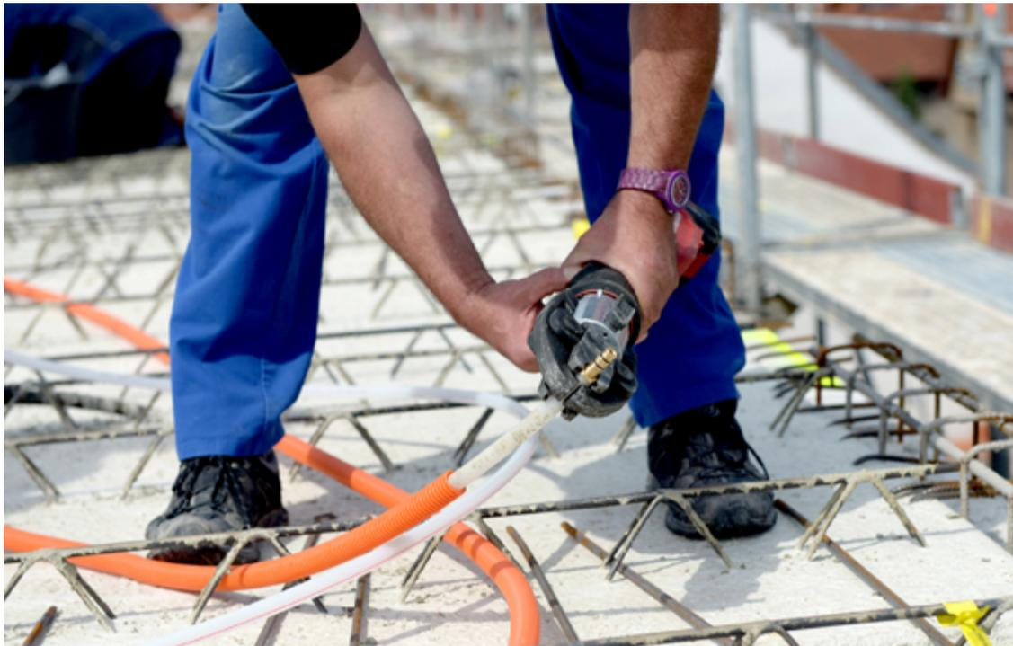
Vor dem Aufbetonieren der Halbfertigteile werden die Heizregister an die Heizkreisverteiler der jeweiligen Wohnungen angeschlossen und abgedrückt; alle Fotos Uponor
