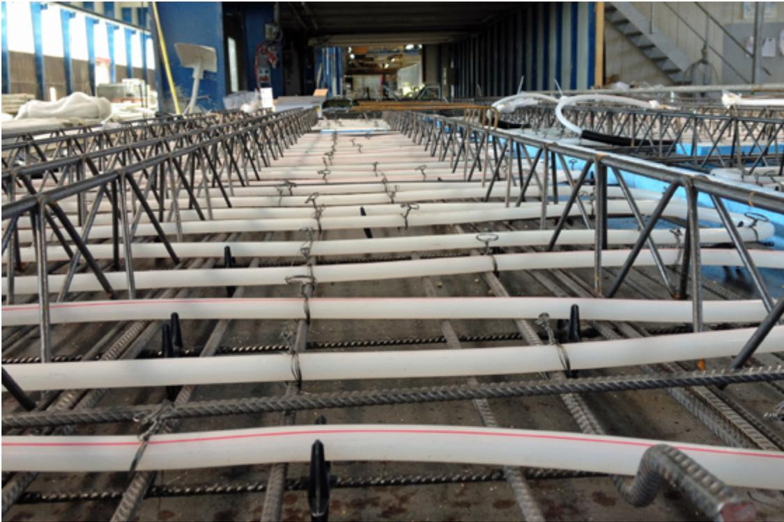
Die Uponor PE-Xa-Rohre wurden in den Beton-Halbfertigteilen im Werk Osterfeld der Heidelberger Betonelemente GmbH & Co. KG installiert.
