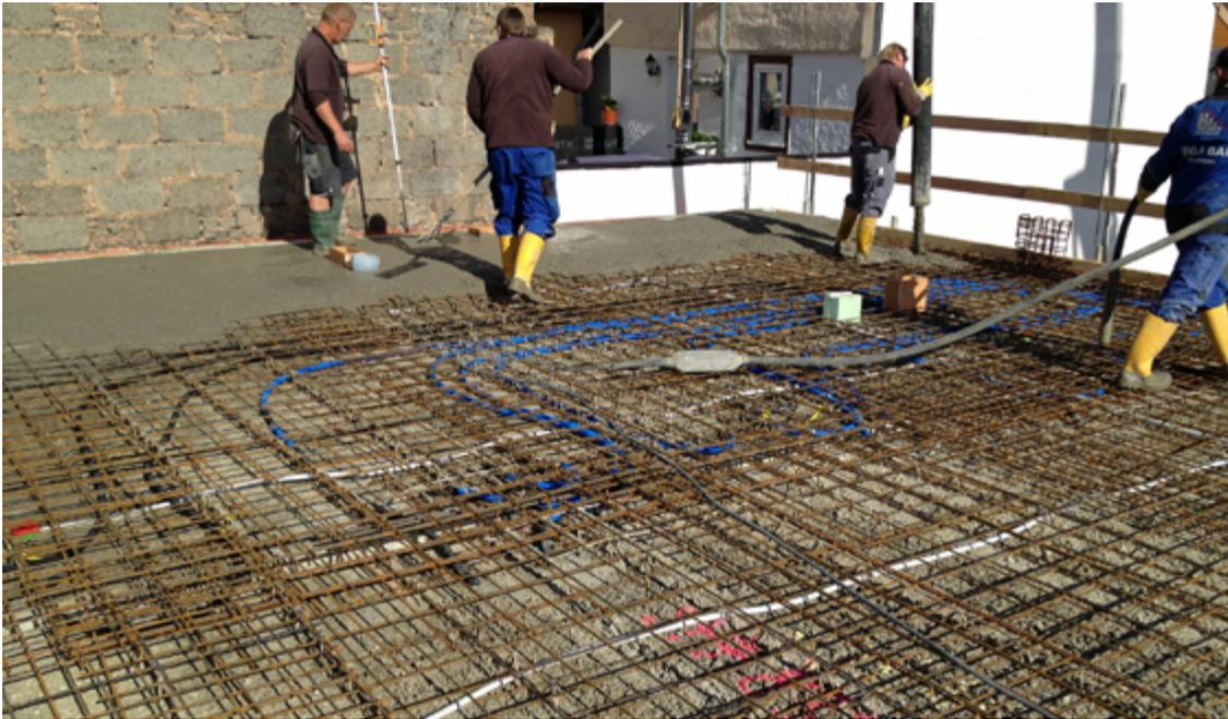
Die Fertigelemente wurden mit 12 cm Ortbeton aufbetoniert. Diese enthalten neben den Heizregistern auch Teile der Elektroinstallation.
