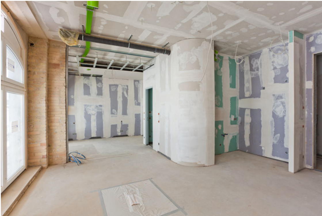
Innenausbau im Trockenbau
