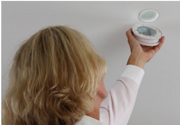
Neuer Rauchwarnmelder; Foto GEV
