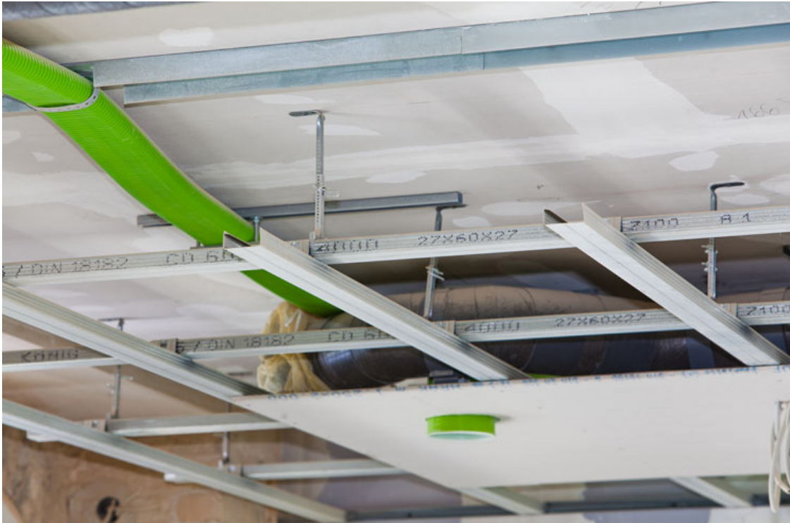
abgehängte Unterdecke
