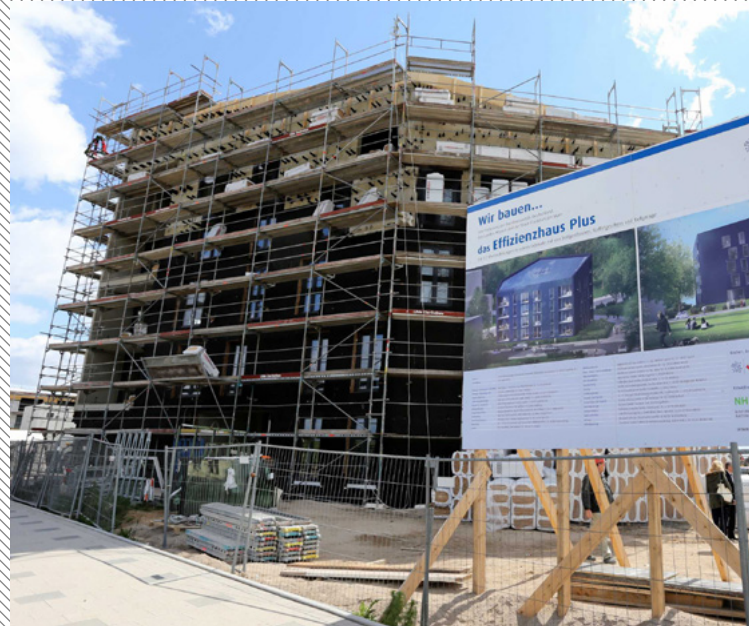
PF2 Richtfest Effizienzhaus Plus, Foto Nassauische Heimatstädte
