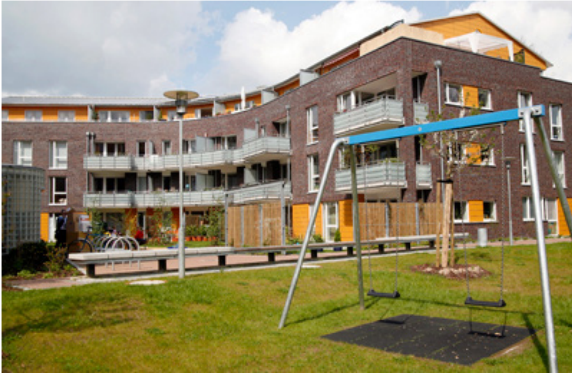
Wohnanlage Ammersbeck III
