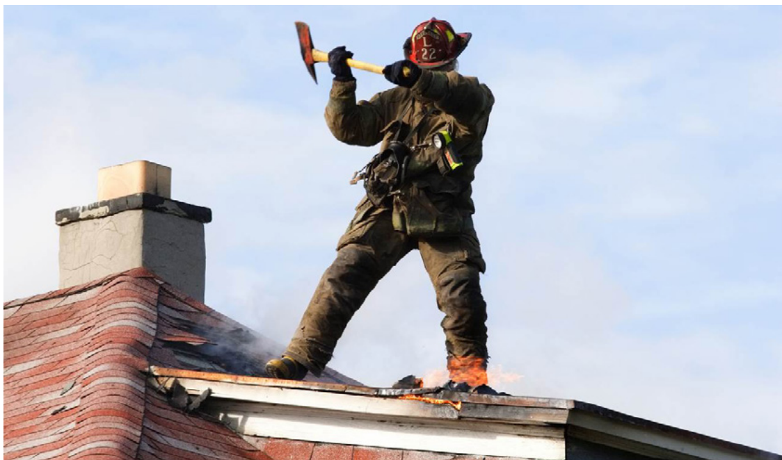
Brandbekämpfung Dachfläche; Foto Solaredge
