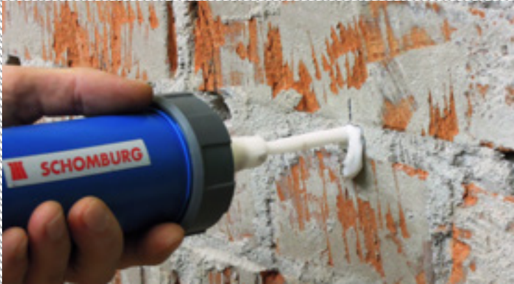
Horizontalsperre; Foto Schomburg
