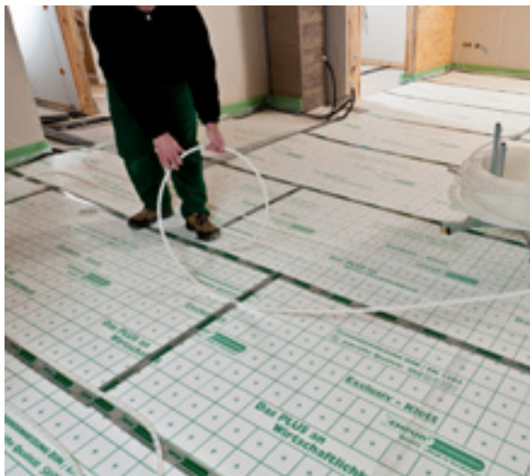
Klett-Verlegung; Foto empur
