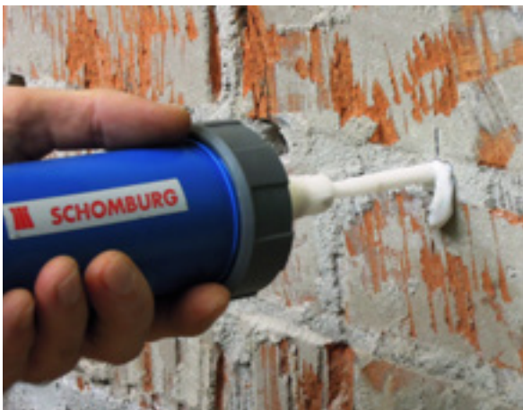
Horizontalsperre; Foto Schomburg
